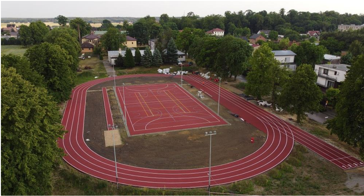
Źródło: tugazeta.pl – boisko w trakcie budowy.
